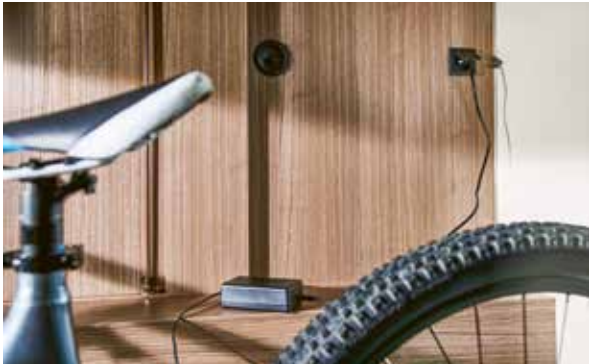
230-V-Steckdose in der Heckgarage
